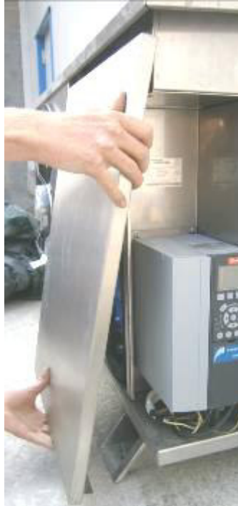
Frontteil unten vom Gerät ziehen
